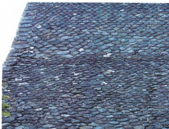
Raccordement des toitures du chevet et de la sacristie
